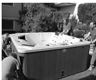
Anschließend wird der Whirlpool in Position gebracht, zentimetergenau ausgerichtet und ins Wasser gesetzt.
