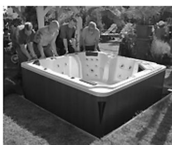
Jetzt kann der Whirlpool mit Wasser befüllt werden. Ein Elektroinstallateur schließt den Whirlpool an und nimmt ihn in Betrieb. Eine ausführliche Bedienungsanleitung liegt bei!
